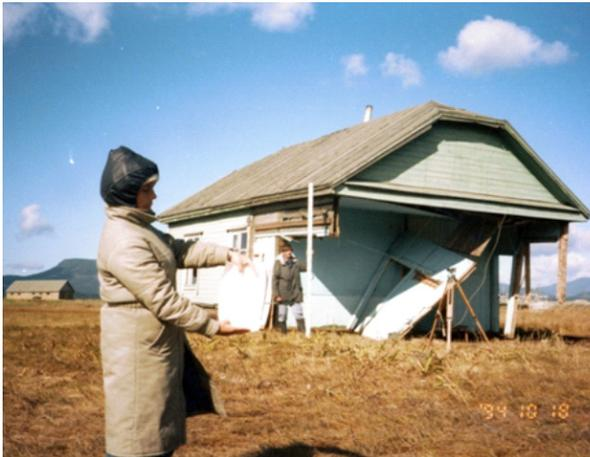
Рис. 3.14. Дом в Южно-Курильске, сорванный с фундамента и унесенный волной цунами на расстояние около 500 м.
