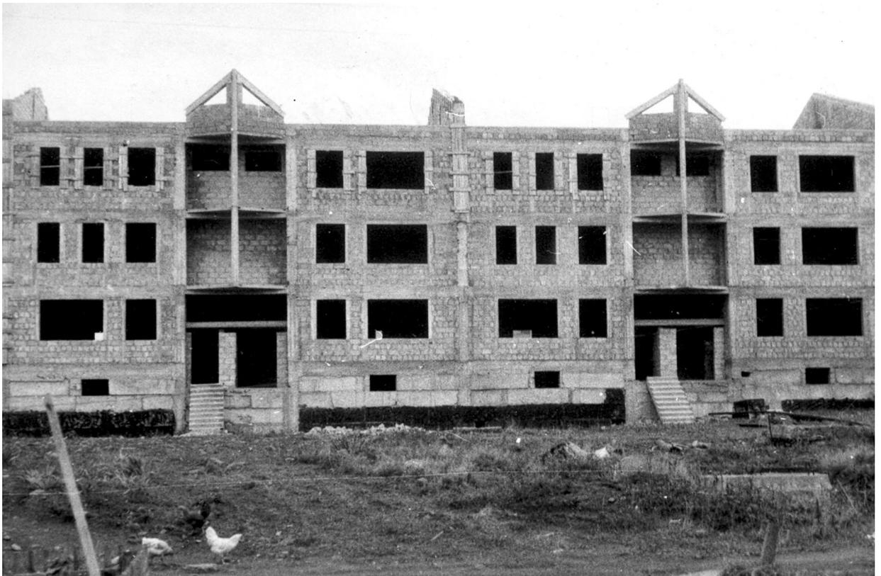
15-секционный жилой дом в Южно-Курильске, наружные стены из мелкоштучных камней (в стадии строительства). При землетрясении обрушились внутренние перегородки и перекрытия. Фото ОАО Институт «Сахалингражданпроект».
