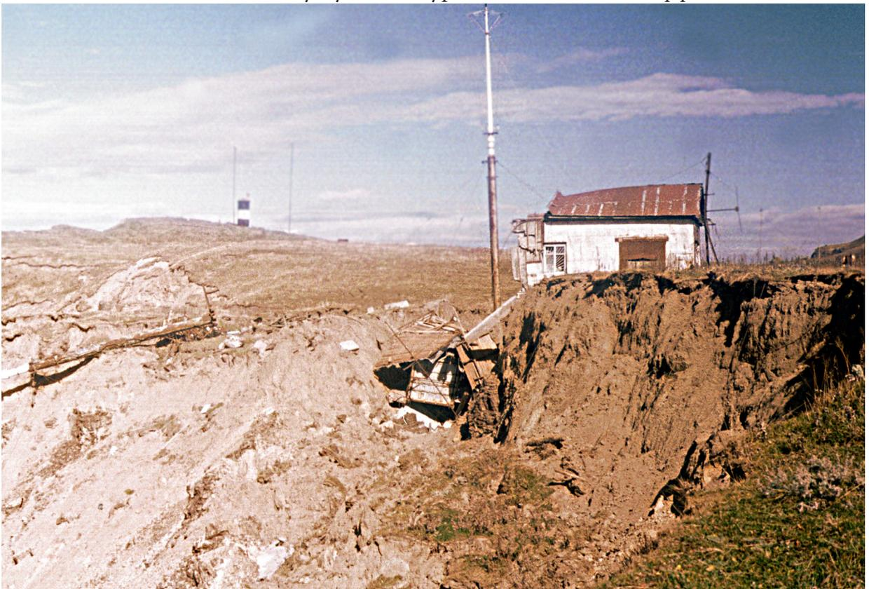
Оползневая трещина отрыва, вызванная землетрясением, под домиком радиостанции на южном мысу, бух. Малокурильская. Фото А.А. Харламова.
