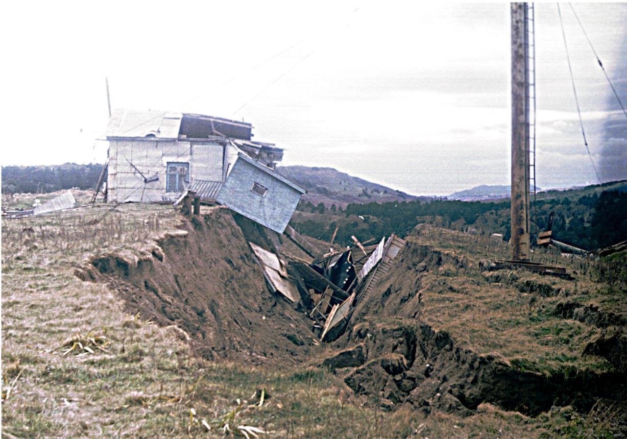
Оползневая трещина отрыва, вызванная землетрясением, под домиком радиостанции на южном мысу, бух. Малокурильская. Фото А.А. Харламова.
