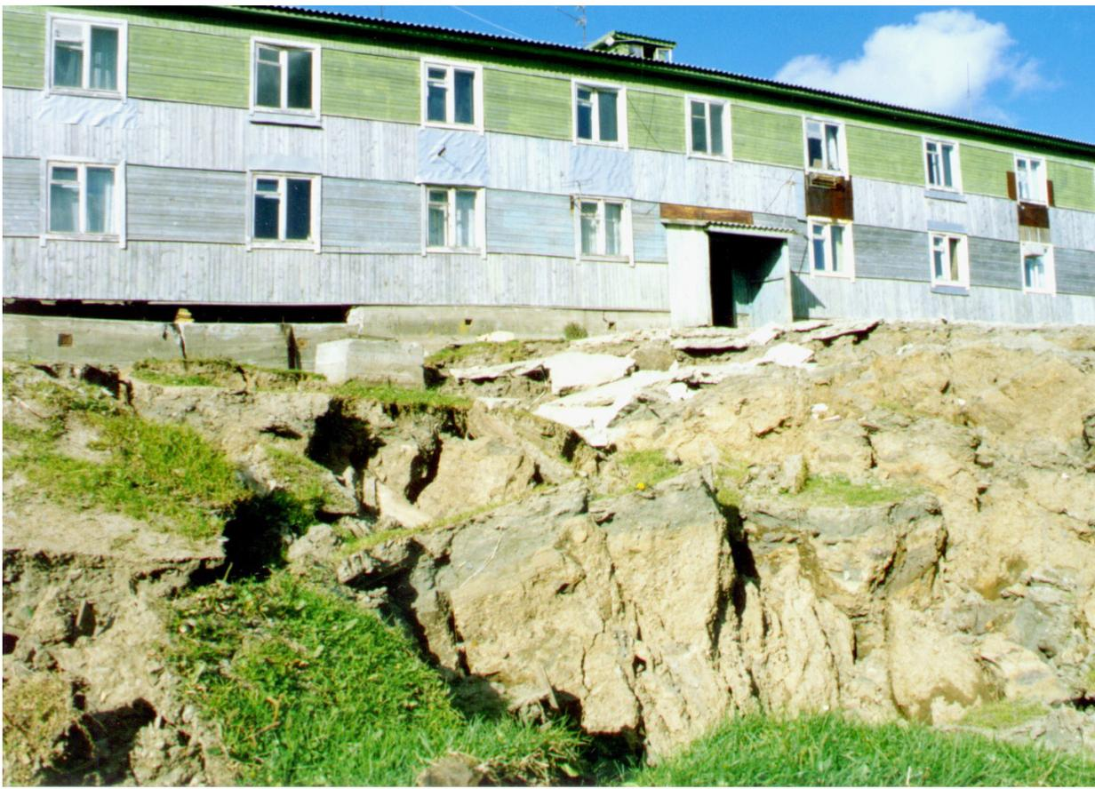
Оползень с многочисленными трещинами в грунте и сильно поврежденное двухэтажное здание №2 по ул. Черемушки в пос. Малокурильское, о. Шикотан. Фото В.К. Гусякова.
