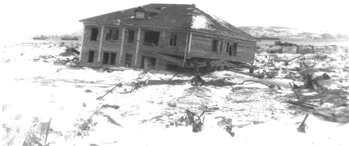
Рисунок 1.2 - Двухэтажный деревянный дом в Северо-Курильске, перенесенный цунами 5 ноября 1952 г. на другое место (Kaistrenko and Sedaeva, 2001).
