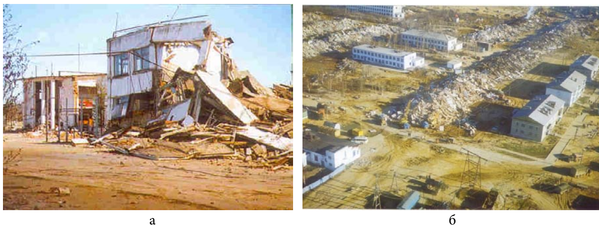
Рис. 1. Нефтегорск после землетрясения. Разрушены магазин и Дом культуры (а). Устоявшие двухэтажные здания и груды развалин бывших пятиэтажных (б). Фото Г.Л. Коффа.
